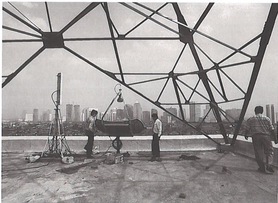
▲ Foto 2 Een van de ontvangschotels wordt geplaatst.
